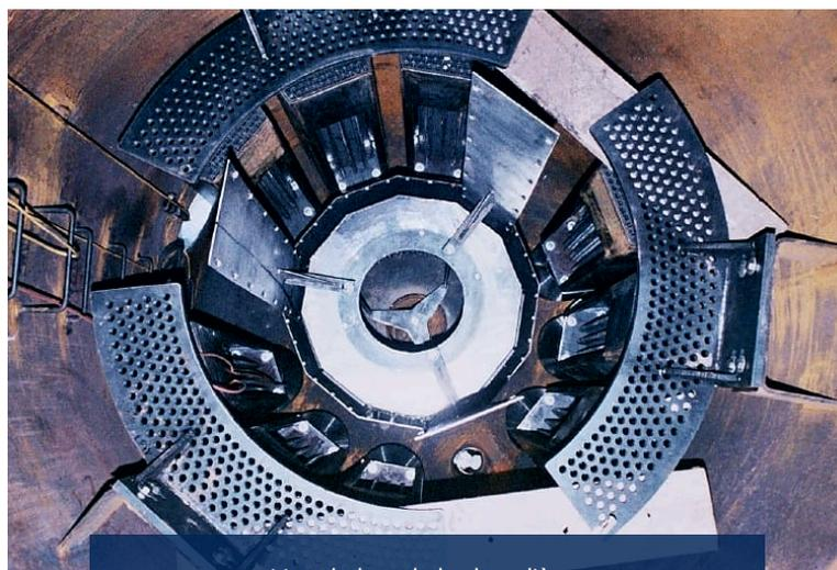
Vue du bas de la chaudière avec 9 boîtes d'électrodes
